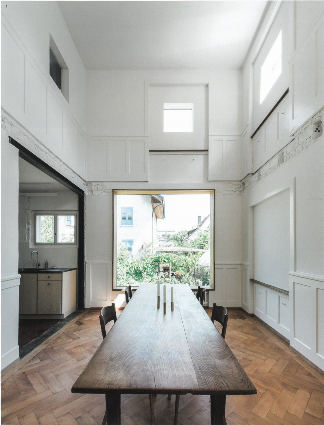
1 Der Essbereich ist der Dreh- und Angelpunkt des Hauses. Die Öffnung zwischen Erd- und Obergeschoss lässt den Brusttäger der oberen Etage zum Gesims werden. Das stark vergrößerte Fenster öffnet den Raum zum Garten.
