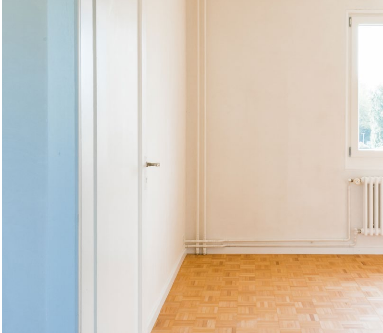
oben: Kalkzementputz und altes Holzwerk / unten: alte Türen und Heizungsinstallationen
