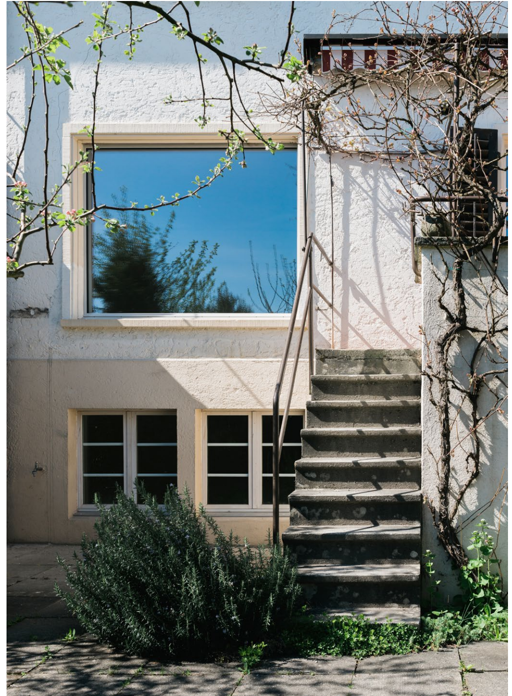
Gartenfassade mit ergänzten Fensterergänden
