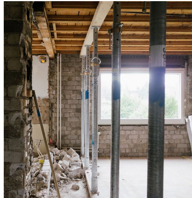
oben: Leichtbau und Zementsteinmauern 1.OG / unten: Kamin und Holzbalkendecke EG
