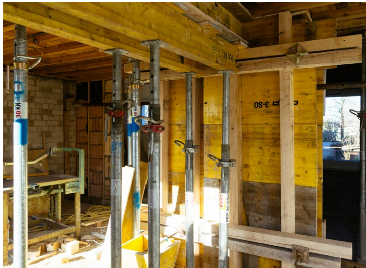
Schalungsarbeiten im Erdgeschoss
